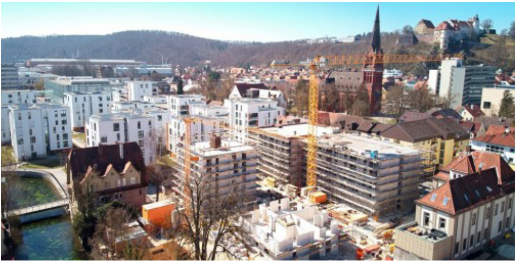
Die Bauarbeiten auf dem Plouquet-Areal gehen voran, vor kurzem war Richtfest. Rechts im Bild, das denkmalgeschützte Gebäude, in dem die Landeszentralbank zu Hause war.
